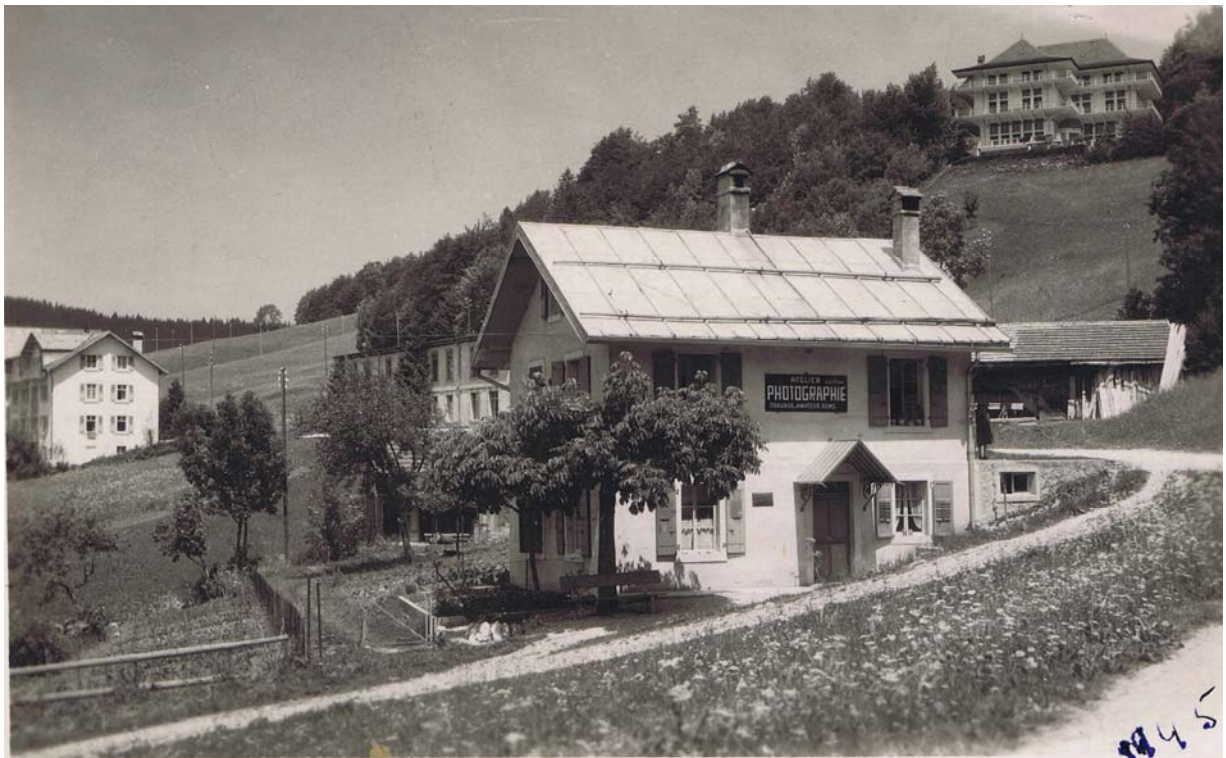
La maison du photographe a bonne mine. Nous sommes en 1945. A l'arrière, dans le haut, la Villa Bunau Varilla, plus bas, la scierie Mouquin. A gauche, l'Hôtel Mon Désir.
